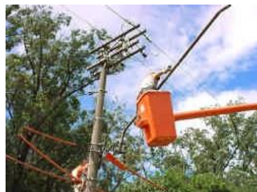
Figura 1 – Condução do suporte tipo braço com cesta aérea
