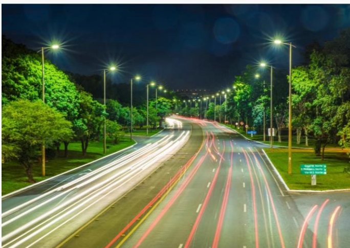
ILUMINAÇÃO LED EIXO RODOVIÁRIO
