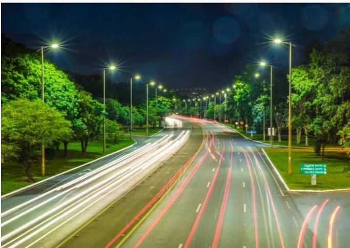
ILUMINAÇÃO LED EIXO RODOVIÁRIO
