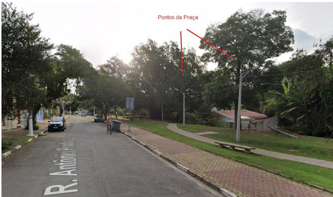
PT 093043 / PT 093044 / PT 093045 / PT 093047 – RUA ANTÔNIO PRADO
