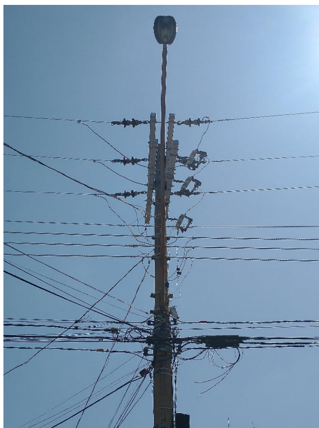
PT 047417 - RUA CUSTÓDIO JOSÉ INÁCIO RODRIGUES
