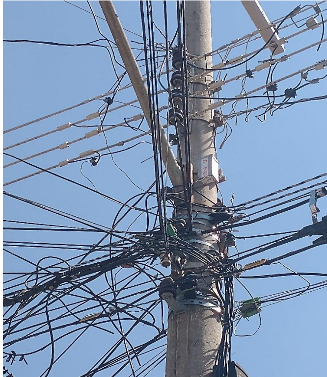
PT 047420 - RUA CUSTÓDIO JOSÉ INÁCIO RODRIGUES
